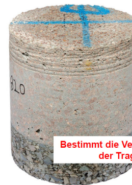
Beton auf ATSuB
